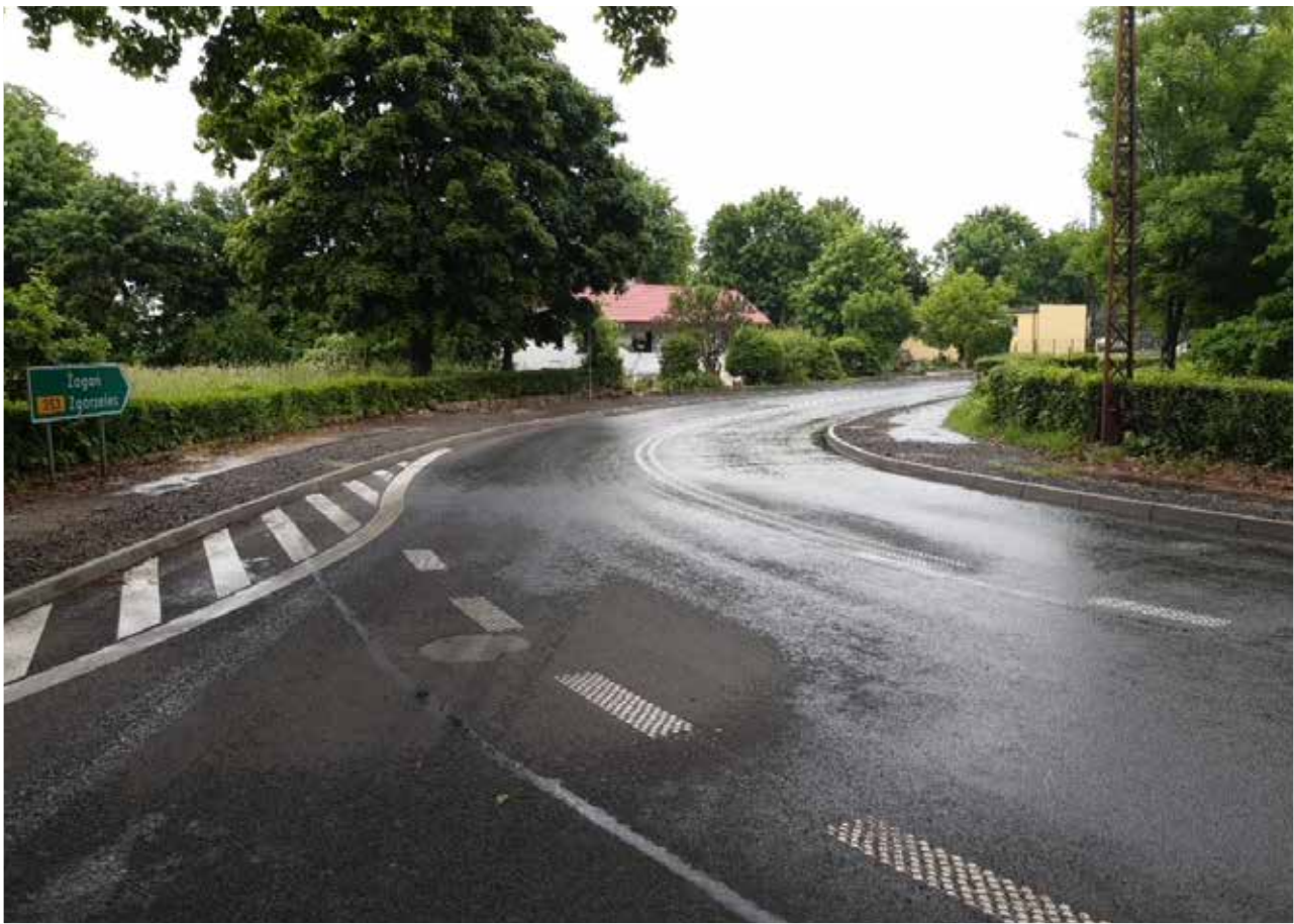
Droga wojewódzka nr 353 / Woiwodschaftsstraße Nr. 353, fot. Dolnośląska Służba Dróg i Kolei we Wrocławiu
