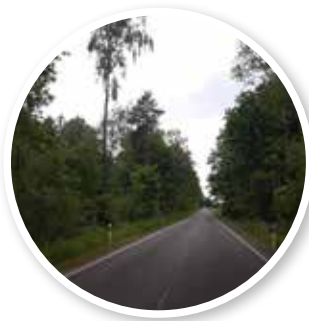
Droga wojewódzka nr 353 / Landesstraße Nr. 353, fot. Dolnośląska Służba Dróg i Kolei we Wrocławiu
