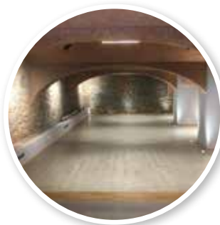
Wyremontowana sala w „Starej Słodowni” – Renovierter Saal in der Alten Mälzerei, fot. Freie evangelische Gemeinde Görlitz
