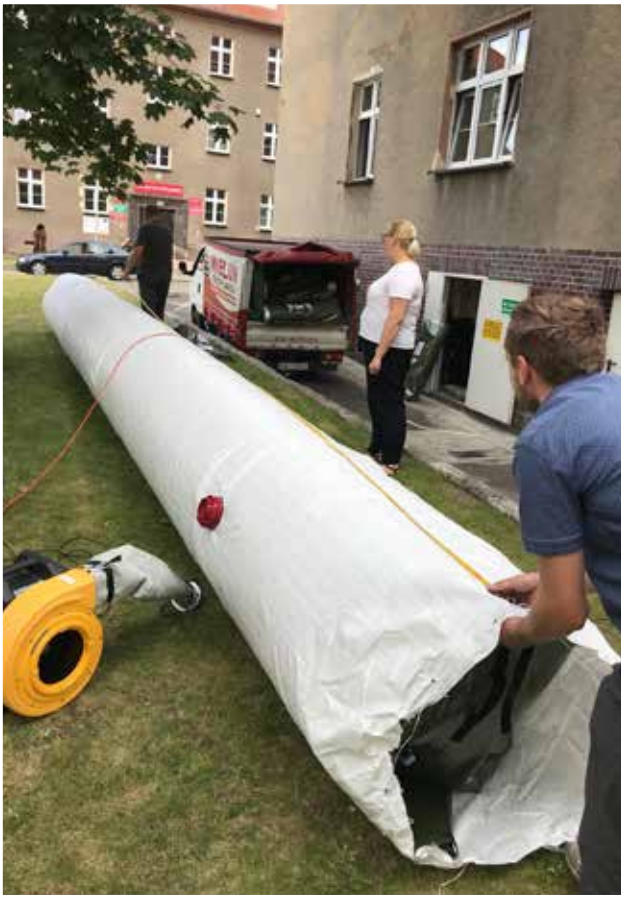
Zapora przeciwpowodziowa / Hochwassersperre fot. Lankreis Görlitz
