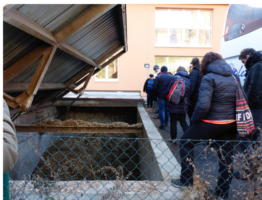
Po lewej zewnętrzny zbiornik na ścinki drzewne posiada mechanizm samoprzemieszczania ścinek w kierunku instalacji (miejsca zasysania ścinek do kotła), po prawej instalacja spalająca ścinki drzewne w szkole [fot. I. Lejcuś]
