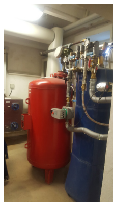
Po lewej zewnętrzny zbiornik na ścinki drzewne posiada mechanizm samoprzemieszczania ścinek w kierunku instalacji (miejsca zasysania ścinek do kotła), po prawej instalacja spalająca ścinki drzewne w szkole [fot. I. Lejcuś]
