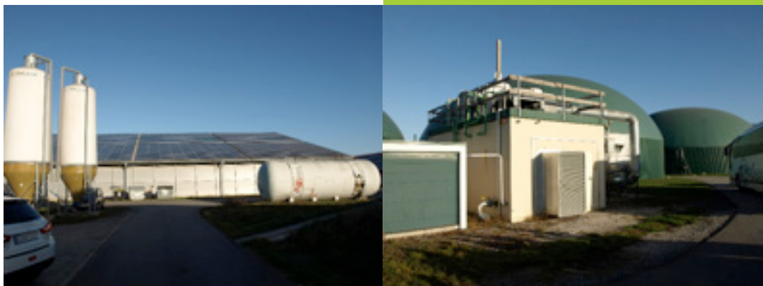
Po lewej obora dla krów z instalacją paneli fotowoltaicznych na dachu, po prawej silosy do biogazowni [fot. I.Lejcuś] Links ein Kuhstall mit Photovoltaikmodulen auf dem Dach, rechts ein Silo für eine Biogasanlage [Foto I. Lejcuś]
